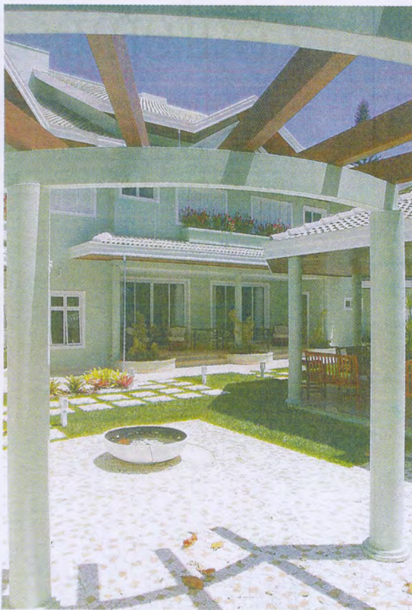
Sobre o piso de mosaico português, o pergulado com pilares de concreto e toras de madeira dão personalidade ao ambiente externo
